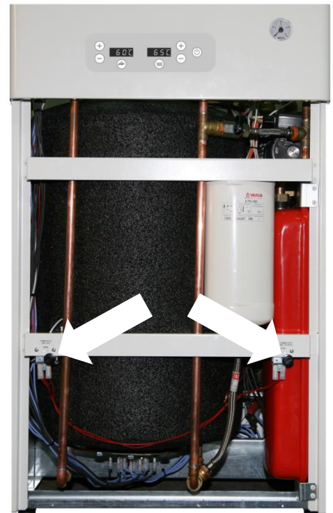
Situación de los limitadores de calefacción, a la derecha, y de ACS a la izquierda en una caldera CMXP
